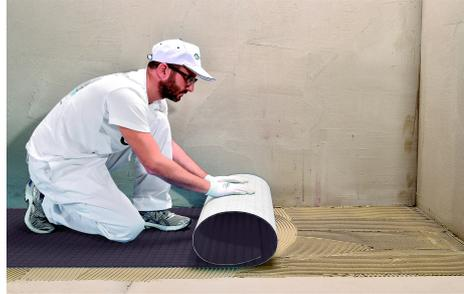
Die Verlege-Membranen gibt es als Platten- oder Rollenware, die Rollenware vorher auf Maß zugeschnitten. Membran vollflächig mit dem Trägervlies in den aufgetragenen Kleber einbetten und sofort mit Hilfe eines Reibbretts oder einer Andruckrolle in eine Richtung arbeitend in den Kleber eindrücken. Die klebeoffene Zeit beachten. Bei der Verlegung von Rollenware ist es zweckmäßig, bereits beim Auslegen die Membran genau auszurichten und unter leichtem Zug straff gespannt aufzulegen.
