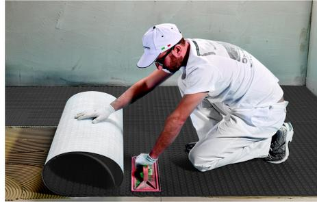
Zur leichteren Verarbeitung ist eine helfende Person sinnvoll. Wegen der Rückstellkräfte der Rollenware wird für die Verklebung im Wandbereich empfohlen die Plattenware zu verwenden. Die Platten bzw. Bahnen werden auf Stoß aneinander gelegt und so ausgerichtet, das die Noppenstruktur einheitlich bleibt. Die Membranen dürfen sich nicht überlappen.
